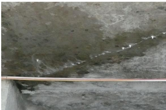
Hình 5. Nứt sàn từ mép vách cứng
