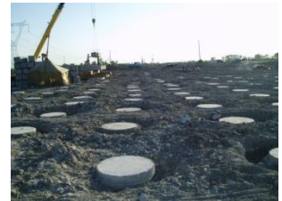
Hình 1. Cọc PCC sau khi thi công
