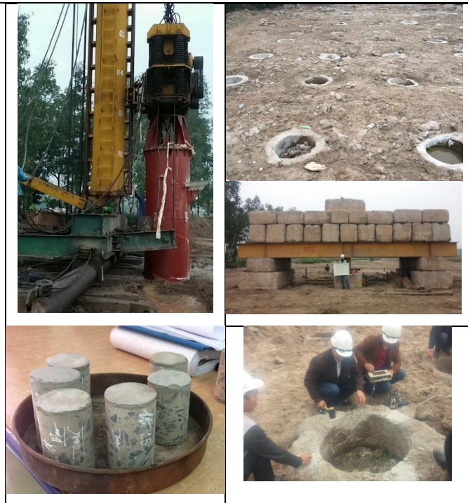
Hình 6. Một số hình ảnh thi công và thí nghiệm kiểm tra chất lượng cọc
